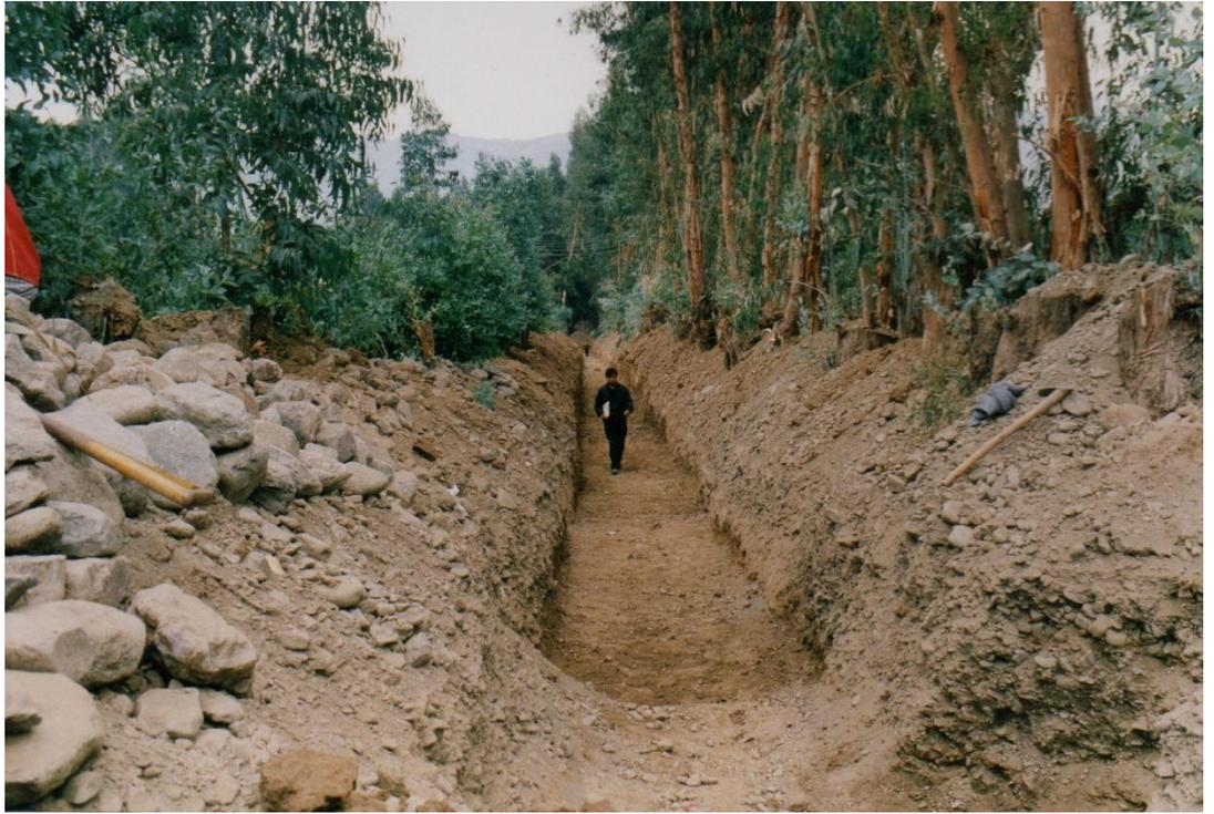
En el área de riego los regantes de Sayt`u Khocha alinean el canal de conducción principal y tienen listo el encobrado para proceder a la construcción del revestimiento de su canal.
