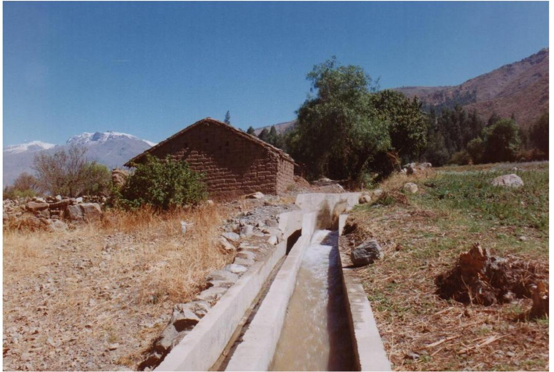
Vale decir que solo fueron construidos para poder conducir aguas de un solo sistema de riego, pero cuando se juntan las aguas de varios sistemas como ser Lagum Mayu (300 l/s), Machu Mit`a (50 a 100 l/s), Chankas (150 l/s) y Sayt`u Kocha (250 l/s); estos canales pueden llegar a tener hasta 800 l/s.; y con 3 sistemas hasta 500 l/s.
